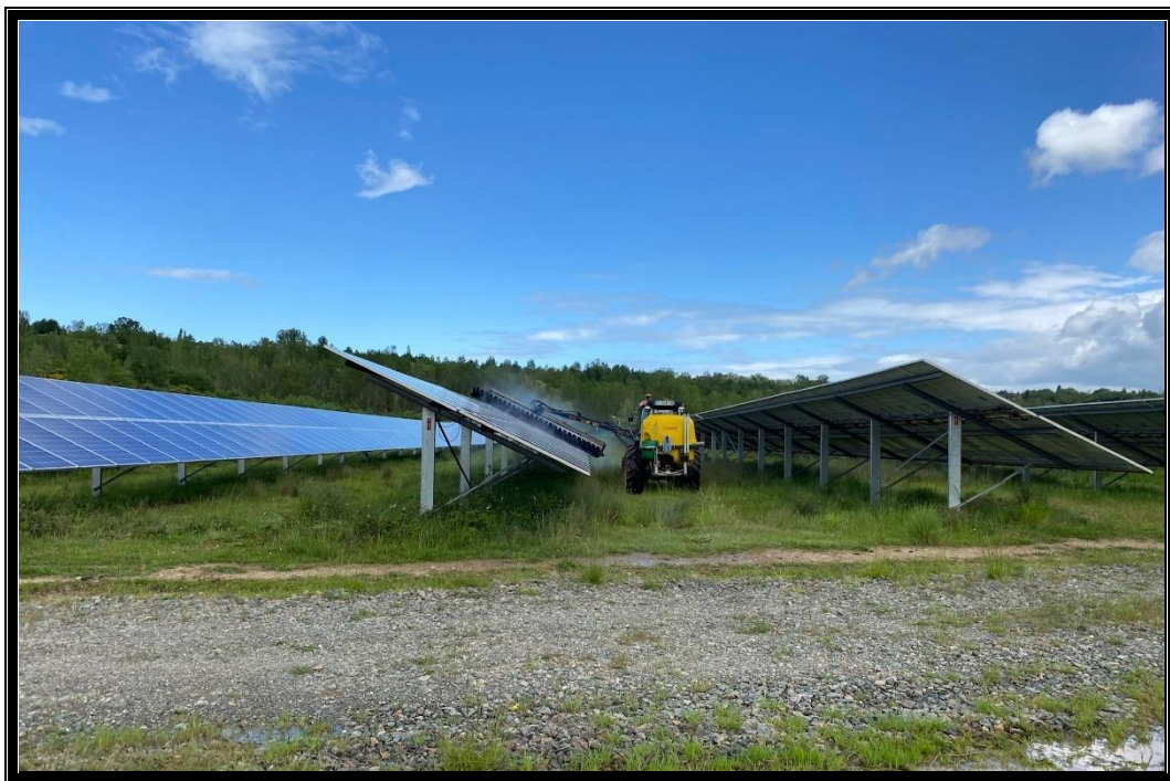
Figure 2: Nettoyage des panneaux sur la centrale de Cap Découverte (81)
